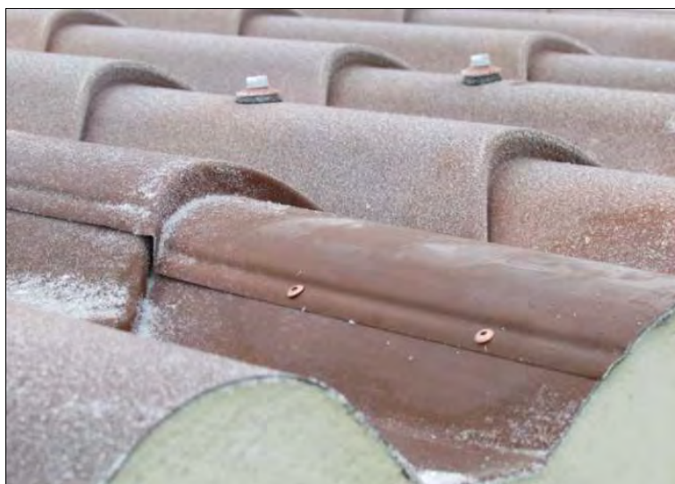
Beispiel des korrekten Einsatzes der Nieten
